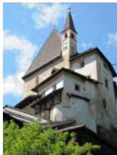
Raggiunto il traguardo a San Romedio
